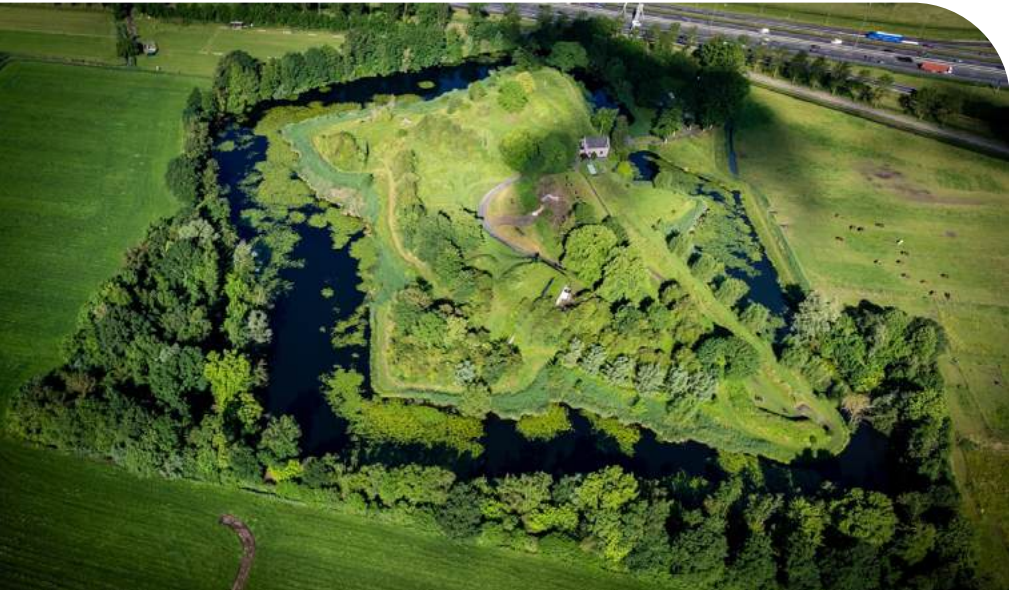
Luchtfoto van Fort 't Hemeltje, een van de forten langs de Hollandse Waterlinies. De stervorm en de grachten zorgen voor veel overgangen; van nat naar droog, van zon naar schaduw. Samen met het beheer maakt dat de forten zo rijk aan soorten.
